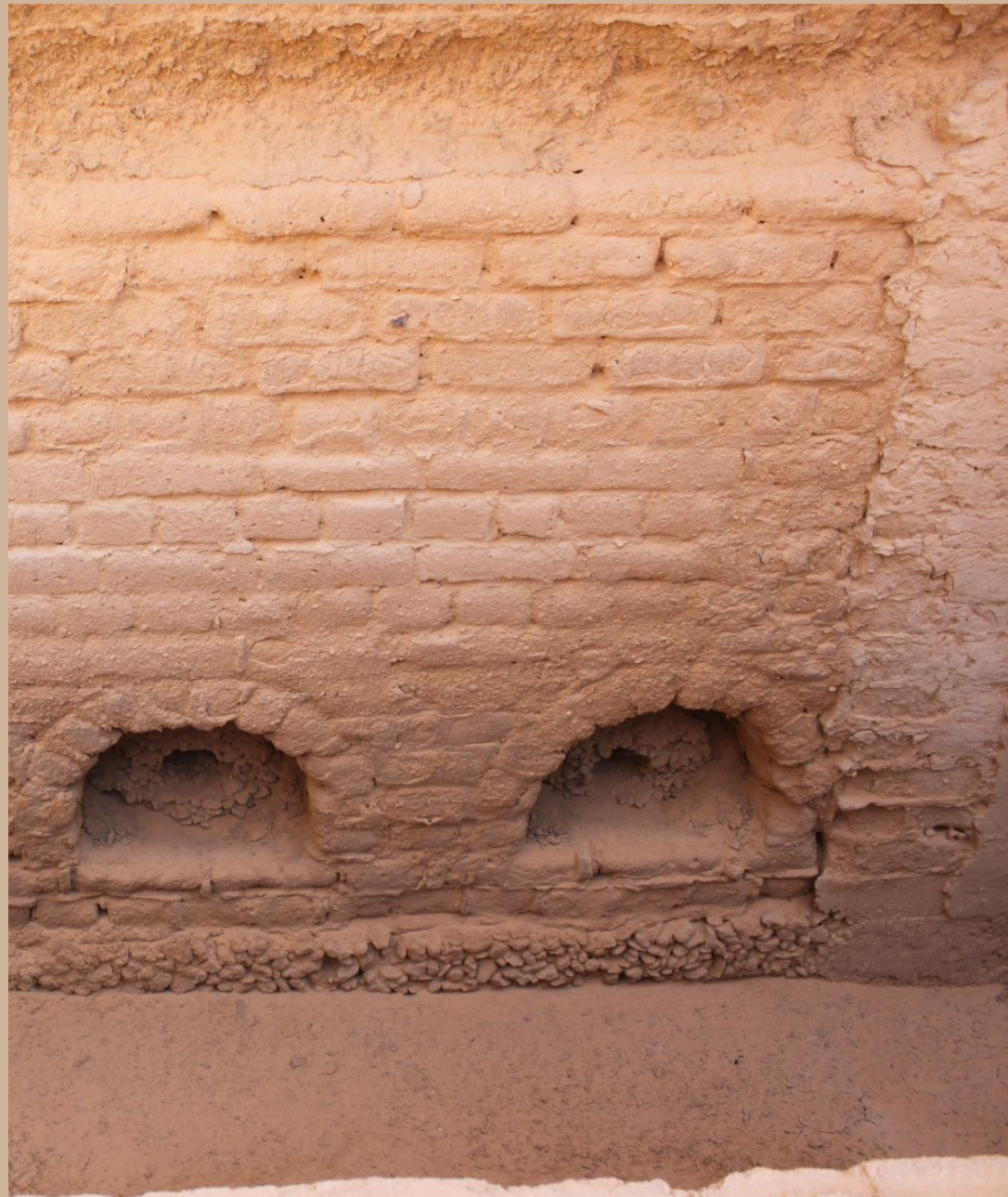
Lehmwand im Königspalast
