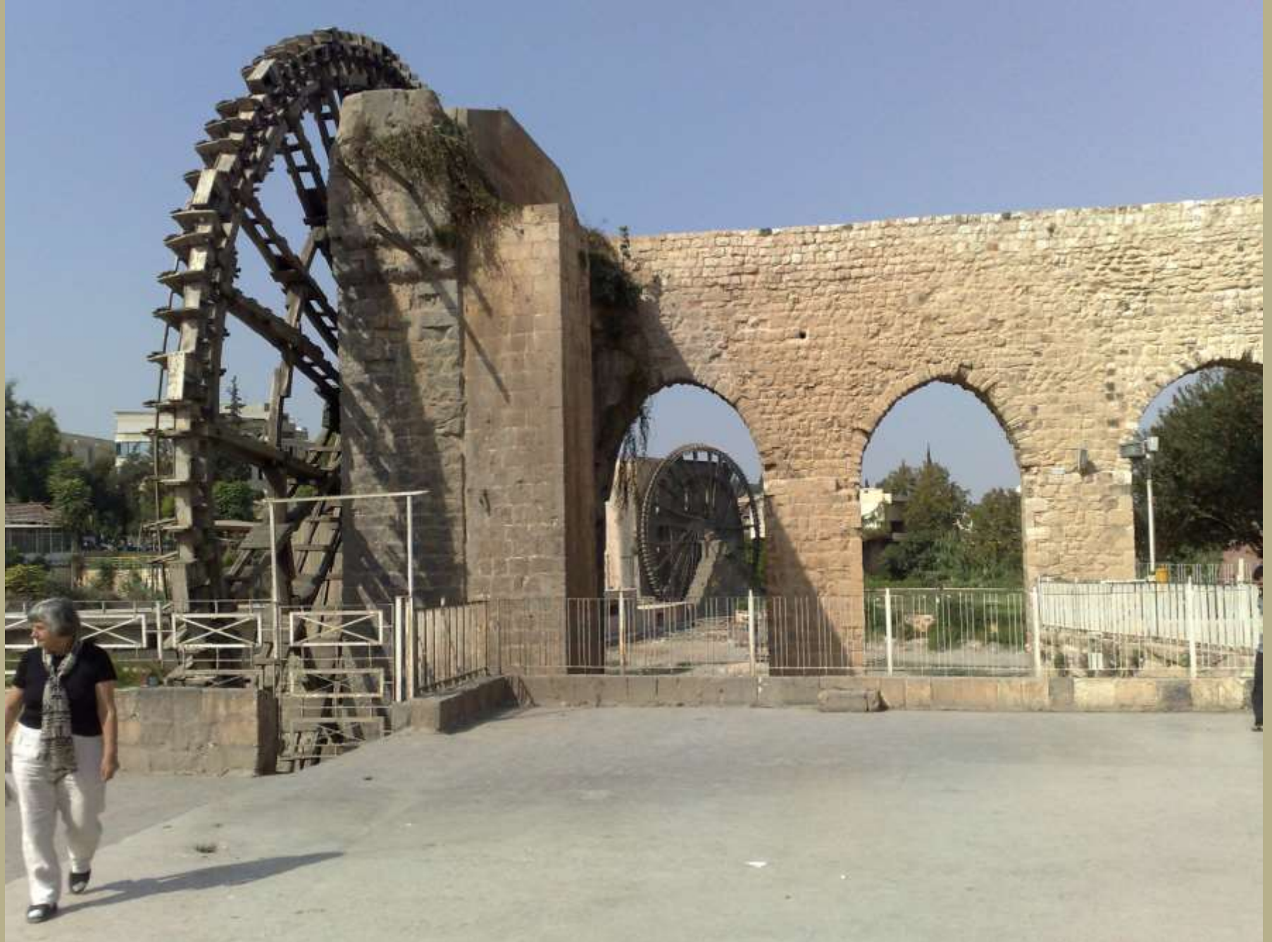
16 Schöpfräder aus dem Mittelalter schöpften bis vor Kurzem das Wasser aus dem Orontes
